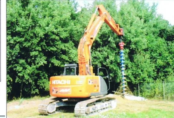
[Figura 10].- *Equipo de sondeo para la instalación de sondas geotérmicas verticales helicoidales.*
