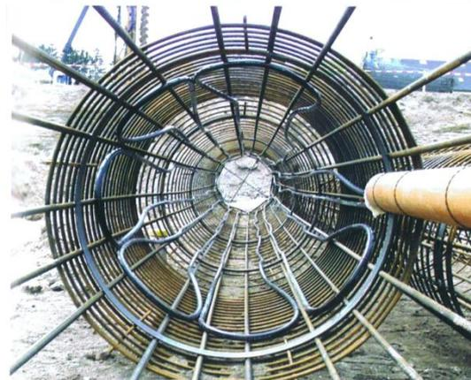
Foto 1.3. Vista en sección transversal de la colocación de las tuberías dentro de la armadura del pilote (Fuente: [www.enercnet.com](http://www.enercnet.com)).
